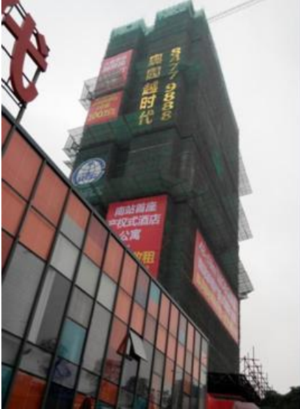
图表 7: 建筑工地
